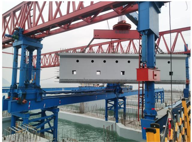
图 8 架桥机安装预制构件
