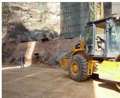
图 2 砂卵石垫层施工
