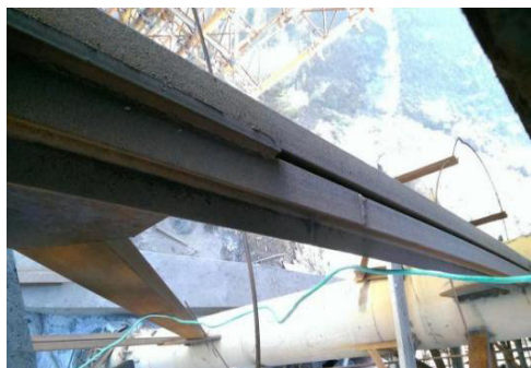
图9 支墩顶部受荷变形区域
