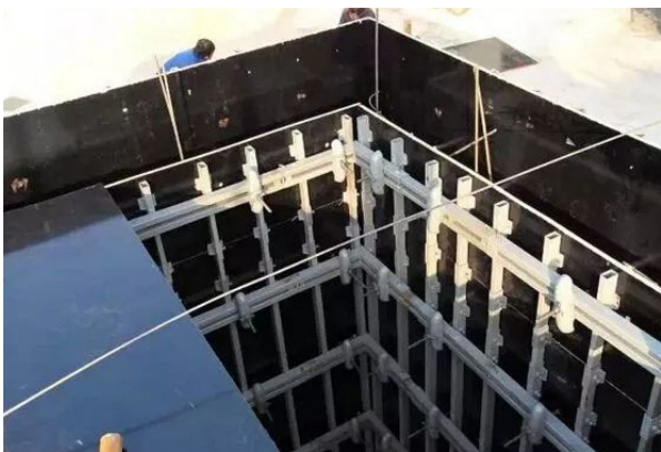
图1 高支模施工体系图
