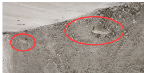
图 20 楼层板加固预埋件现场图
