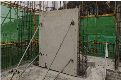
图 12 竖向 PC 构件吊装固定完成图
