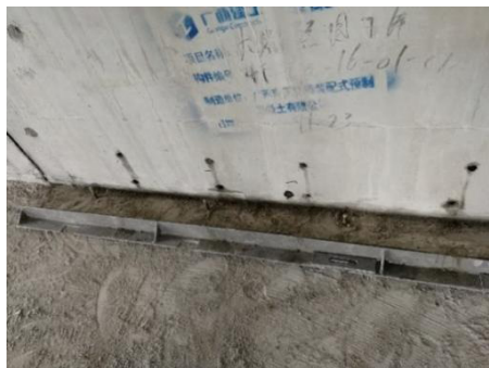
图 26 可周转式封堵装置拆除过程图
