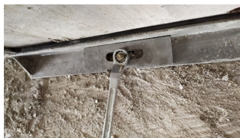
图 22 可周转式封堵装置加固过程图
