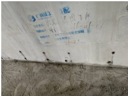
图 27 高压注浆完成后拼缝成型效果图
