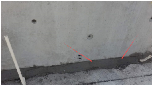
图 3 砂浆外三角封堵施工工艺完成封堵图
