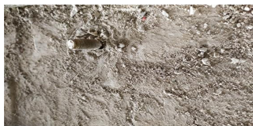
图 21 封堵装置加固预埋件清理完成图
