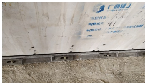
图 23 可周转式封堵装置封堵完成图
