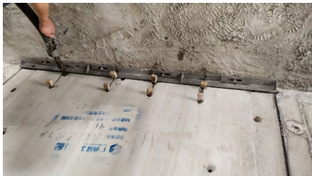
图 25 灌浆料高压注浆完成图
