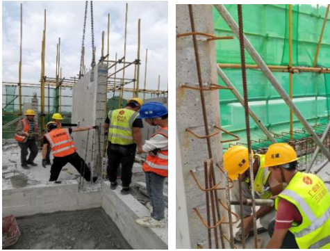
图 11 竖向 PC 构件吊装过程图
