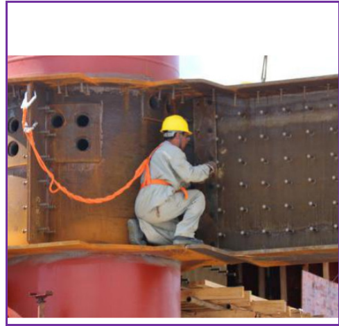
图6 利用定位组装板临时固定、牛腿腹板开始焊接
