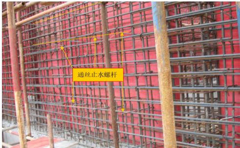
图4 支好内模后穿通丝止水螺杆
