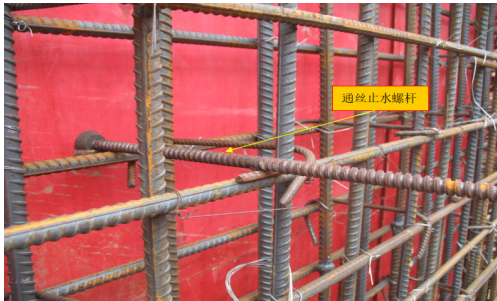
图5 通丝螺杆安装须平直
