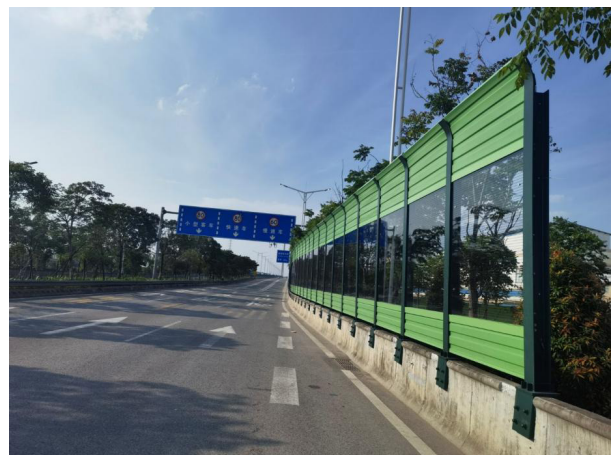
图1 公司承建的中国广东佛山市顺德区伦桂路声屏障工程
