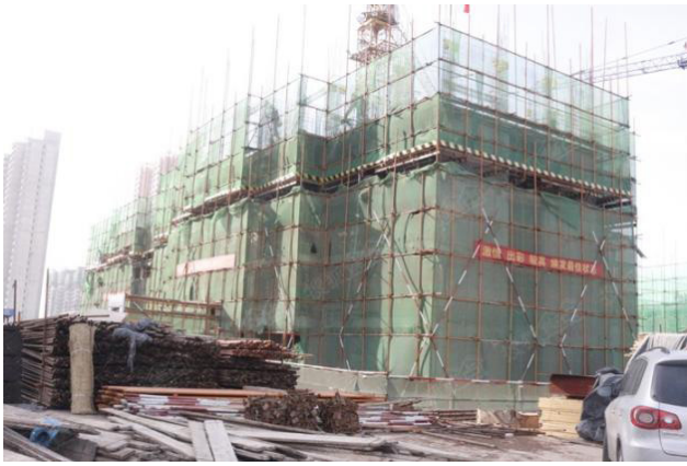
图2 高层建筑施工
